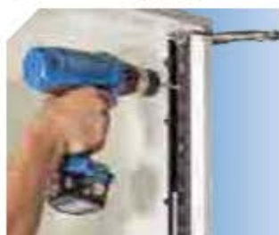
Отверстия для установки дверных петель.
