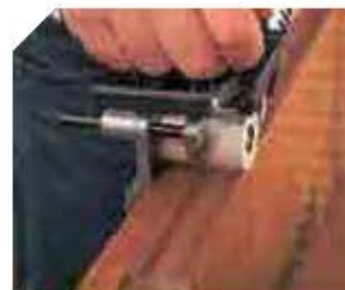
Облицовка на верхней поверхности ступенчатой двери.
