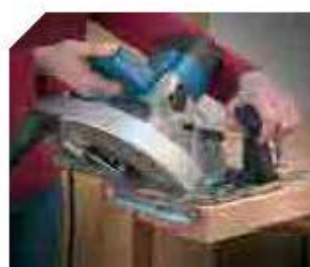
Выполнение наклонного реза.
