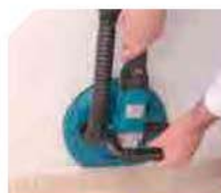
Обработка зон стыков при демонтаже сегмента защитного кожуха.
