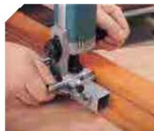
Прорезка паза на окне со стороны замка.
