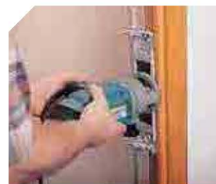
Установка петель при помощи насадки для работы по шаблону CPN66.
