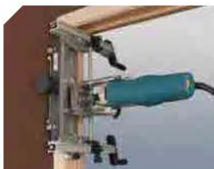
Фрезерование посадочного места верхней петли в дверной коробке.
