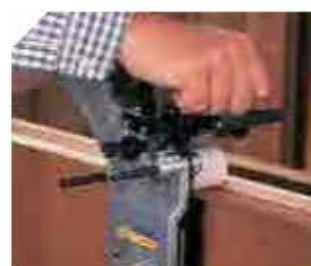
Облицовка внутренней стороны выступа на ступенчатой двери.
