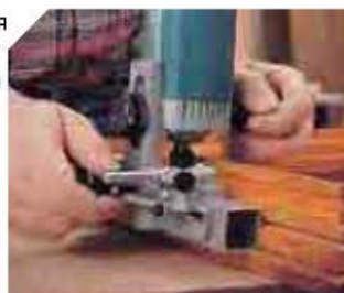
Прорезка паза на окне со стороны в осток.
